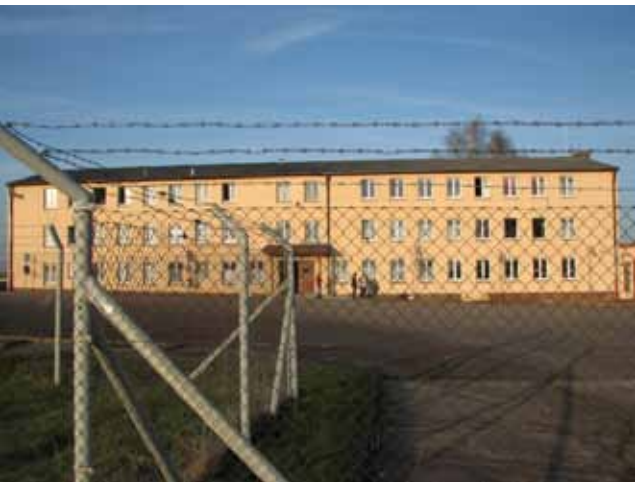
Lagerleben im 21. Jahrhundert: Die GU Hardheim im Neckar-Odenwaldkreis ist eine ehemalige US-Kaserne. Der Zustand des Gebäudes, die hygienischen Verhältnisse und die soziale Versorgung sind schlecht, bis zu 8 Personen, auch die Familien, müssen in jeweils einem Zimmer wohnen, zum Teil über viele Jahre. Bis zur nächsten Stadt (Mosbach) sind es 40 km.
